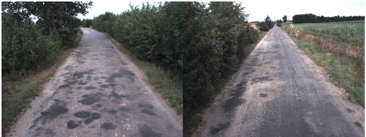
DP nr 1145C odcinek od km 2+550 do km 3+600
