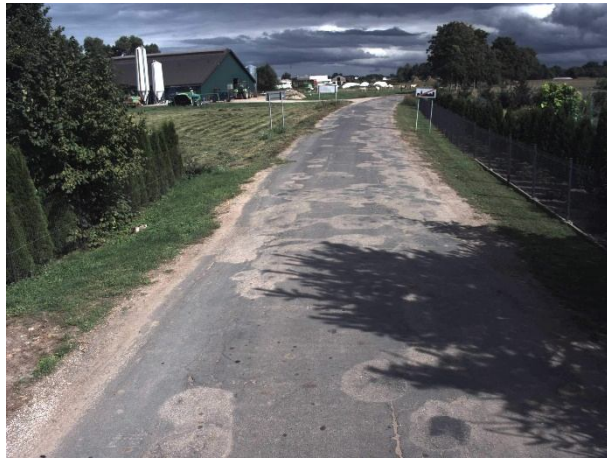
DP nr 1135C odcinek od km 0+003 do km 0+325
