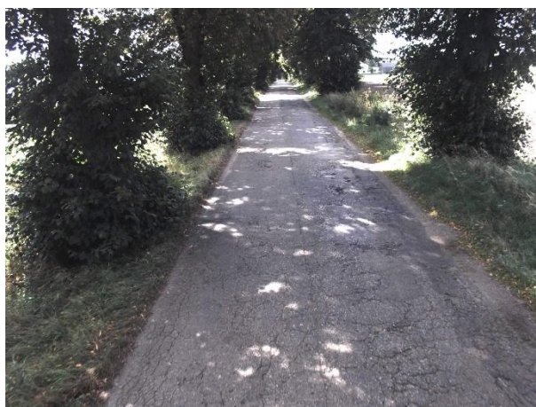
DP nr 1132C odcinek od km 8+860 do km 9+615
