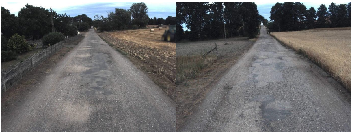
DP nr 1146C odcinek od km 3+080 do km 4+169
