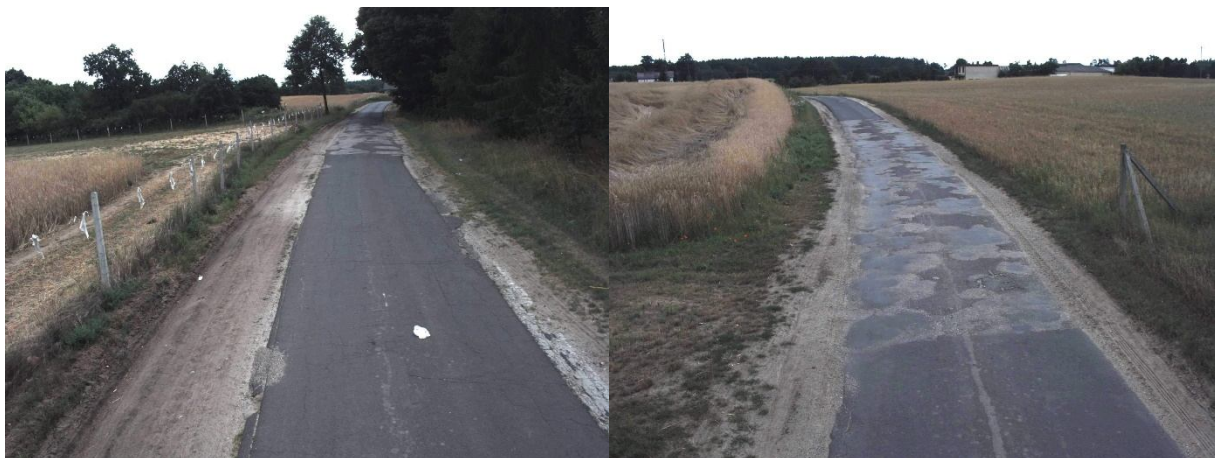
DP nr 1125C odcinek od km 3+291 do km 4+323
