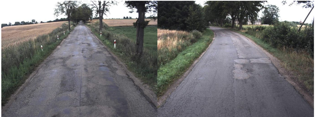
DP nr 1120C odcinek od km 4+776 do km 5+090
