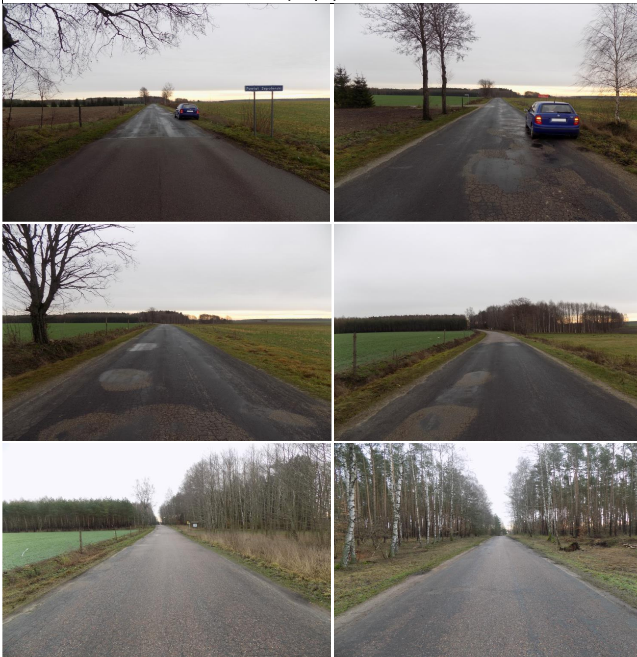
odcinek zlokalizowany między km 0+000, a km 1+000
